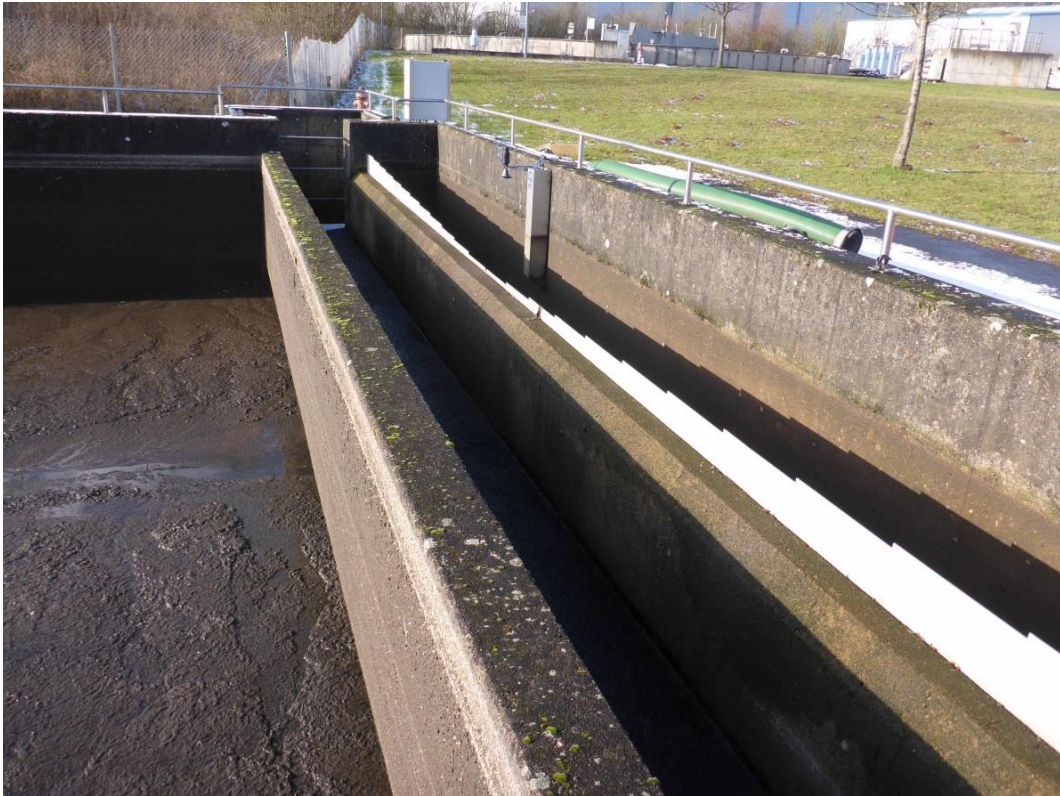
Abbildung: Abflussmessung mit Stufenmesswehr Kläranlage Lebach
