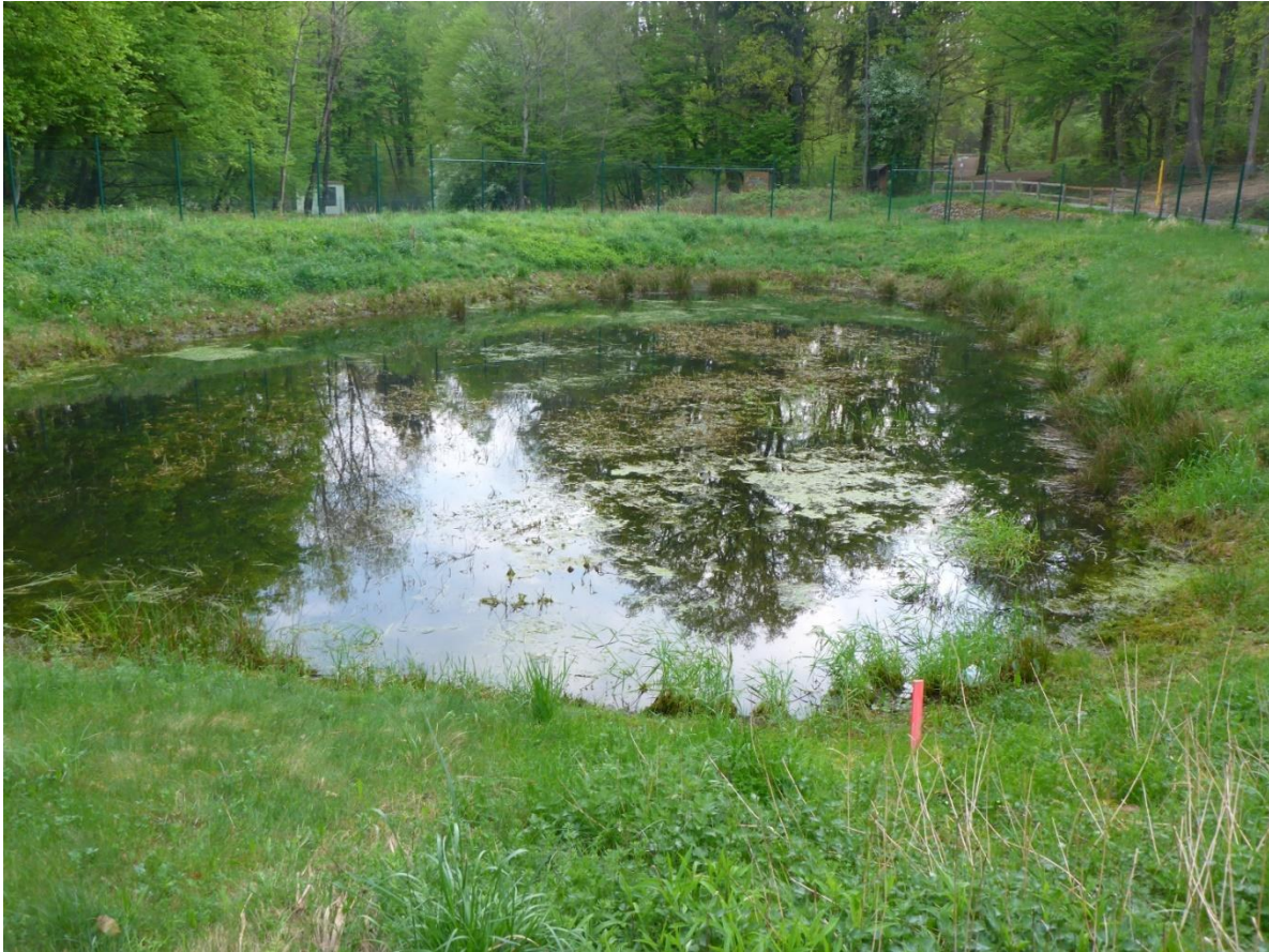
Abbildung: Foto Retentionsbodenfilter
