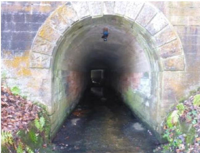
Abbildung: Durchlass mit Füllstandssonde / Füllstandssonde
